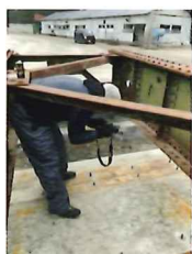
橋げたの近接撮影
