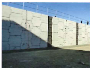
コンクリート壁のドローン撮影
