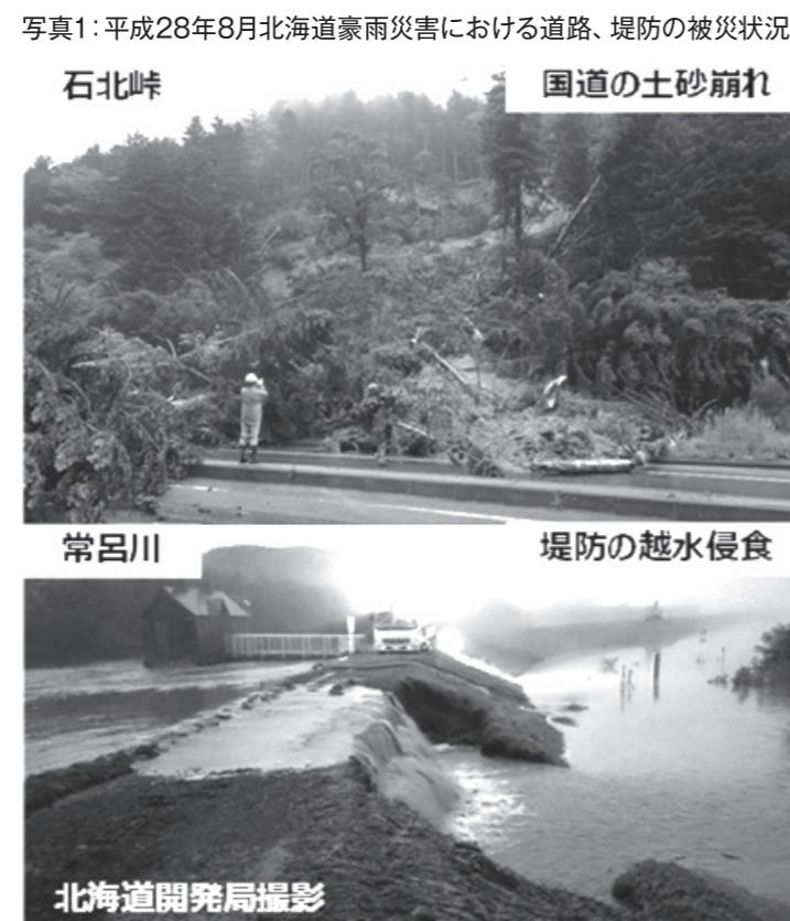
写真1: 平成28年8月北海道豪雨災害における道路、堤防の被災状況
