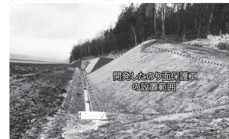
るよう砂質土を充填しています。さらに、2層目の上は植生シートや張芝によって緑化します。なお、この工法では、降雨や融雪によって砂質土層(2層目)に浸透した水は、粒径と保水性の違いによって碎石層(1層目)への浸透が抑制され、砂質土層内を流下しようとする浸透抑制機能が期待できます。
