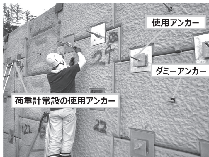
写真1：竣工後の計測の様子
