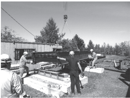
a) 鋼部材の搬入
