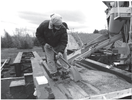
d) コンクリート打設
