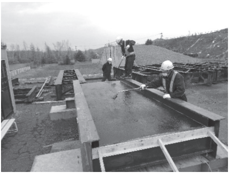
f) 舗装施工
