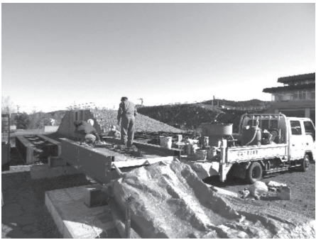
e) モルタル打設
