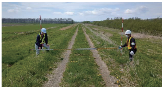
図1：堤防点検の様子
