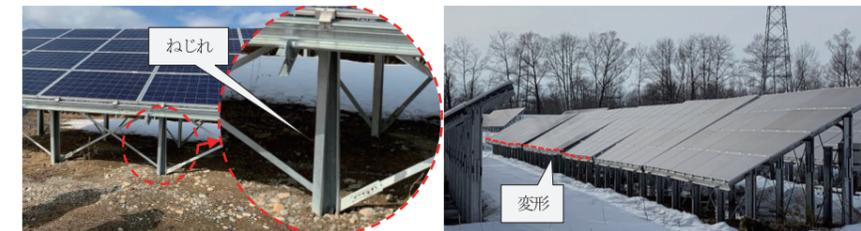
写真1：凍上による被害事例
