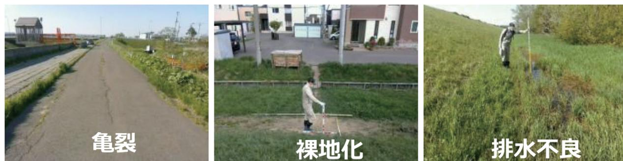
図1：現地での堤防診断の様子
