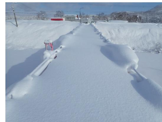
写真3：積雪状況(2025/1/17撮影、橋上の積雪水量：190mm w.e.)
