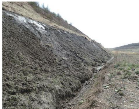
図1：岩盤斜面の凍上被害の一例
