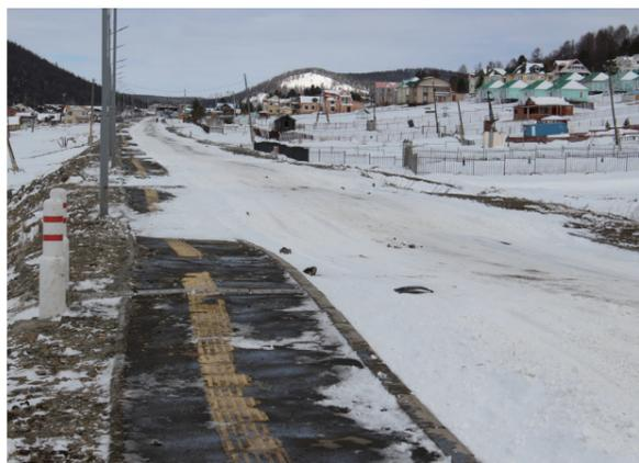
図 1：凍上・沈下により生じた道路の変状
